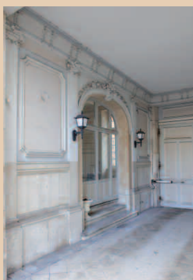
Intérieur du porche, côté escalier.
