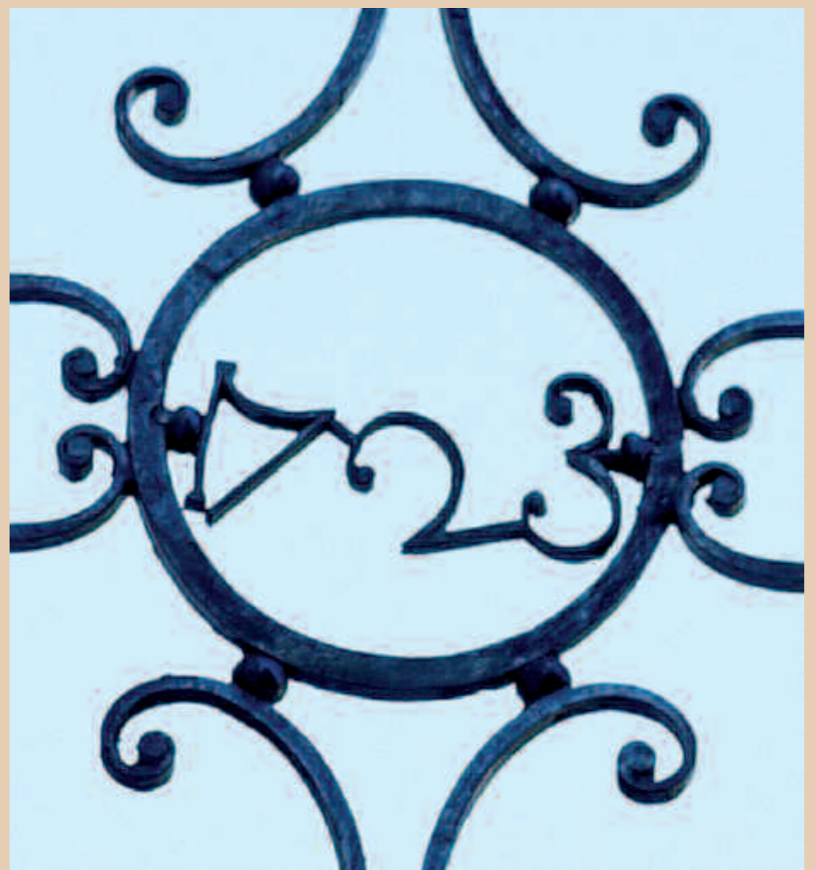
Garde-corps du balcon.
