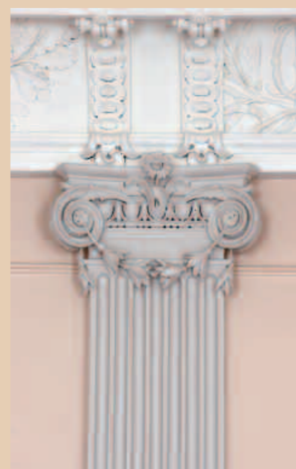
Détail d'un chapiteau de la cage d'escalier.
