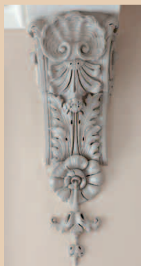
Détail d'un culot supportant le palier de l'escalier.
