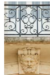
Balcon de la cour administrative d'appel de Nancy
